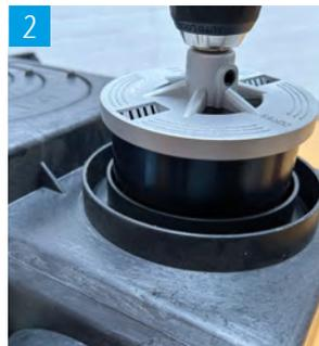
2 Bohrkronen mithilfe des Zentrierbohrers mittig ansetzen.
