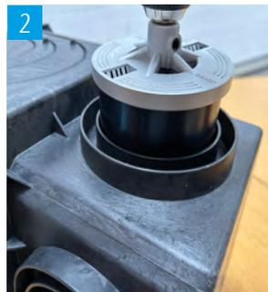
Bohrkronen mithilfe des Zentrierbohrers mittig ansetzen.
