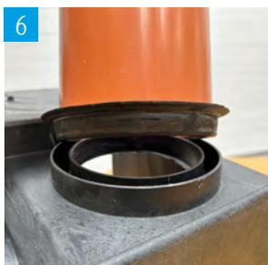
6 KG-Doppeldichtung inklusive PVC-Stutzen zwischen dem mittleren und äußeren Ring mit ausreichend Druck platzieren.
