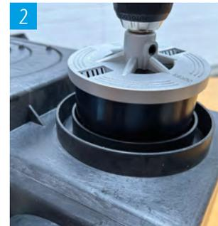
2 Bohrkronen mithilfe des Zentrierbohrers mittig ansetzen.
